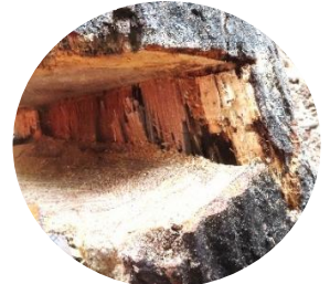
ツル部分の腐食
