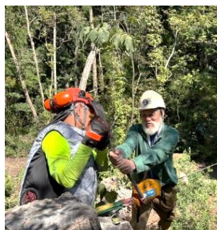
チルホールのレバーを引く！
