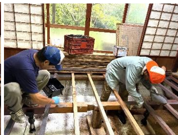
床基礎防腐剤塗布
