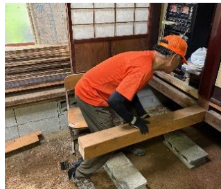
母屋の床材基礎修繕
