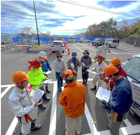
作業前の打ち合わせ。当日の作業を周知する。
