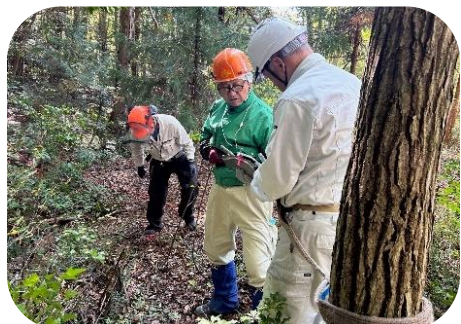
ロープ、チルホール設置中
