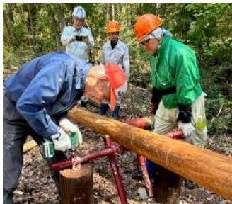
シーソー支柱に取付作業
