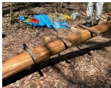
シーソーの持ち手の取付
