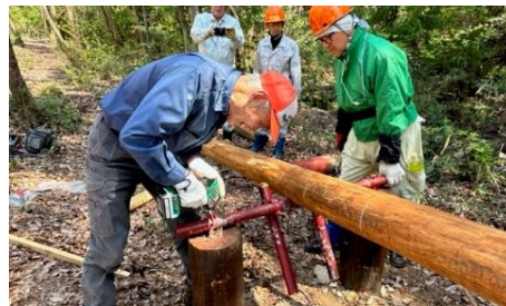
安全第一。遊具の点検
