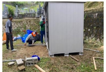
倉庫内機材の運び出し → 基礎ブロック水平取り → 基礎ブロック敷き詰め完成 → 右側倉庫後方へ移動
