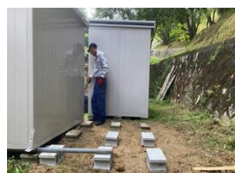
倉庫内機材の運び出し → 基礎ブロック水平取り → 基礎ブロック敷き詰め完成 → 右側倉庫後方へ移動
