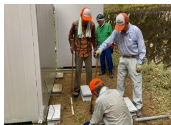
倉庫内機材の運び出し → 基礎ブロック水平取り → 基礎ブロック敷き詰め完成 → 右側倉庫後方へ移動
