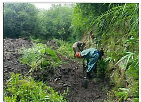
イノシシが掘り起こした歩道を整備！
