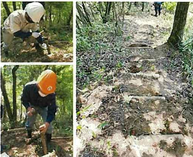
一本一本杭を打ち、立派な階段に仕上がりました。
