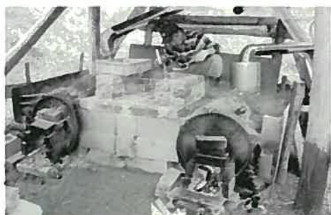
2基の炭焼き窯の間にピザ窯を作りました。溶鉱炉の中古耐火レンガを頂きモルタルで作る本格的ピザ窯の完成！(16.5.9)
