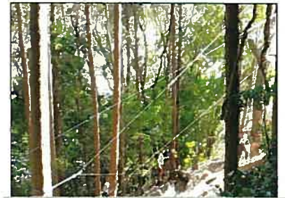
より確實により安全に。3方向からのロープ掛け
