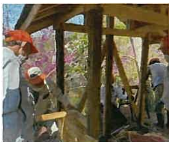
手すり、壁材取付の様子
