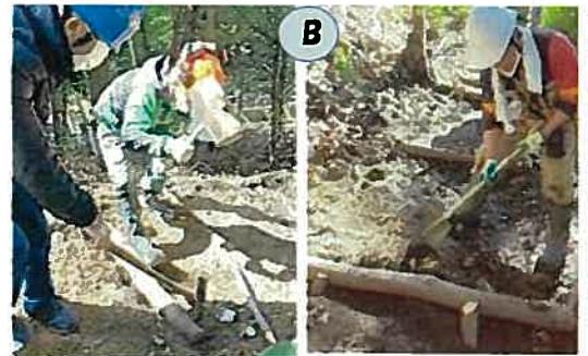
材の調達に手間取りつつも、参道の補修完了
