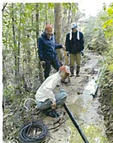
土砂を取り除く水道タンクの修繕
