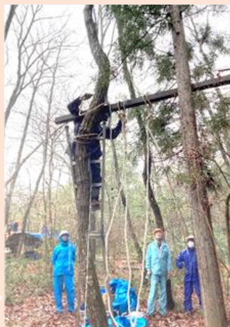
ブランコでは安全帯を着用しての高所作業となりましたが無事に設置。
