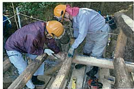
スクウスクウの森の山裾に建ちます； あずまや 四阿の遠景(左上) あずまや 四阿仮組み(右上) 基礎工事(下左) 棟組み作業中(下中・右)
