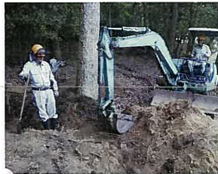
基礎工事中。コンボ担当は川原さん
