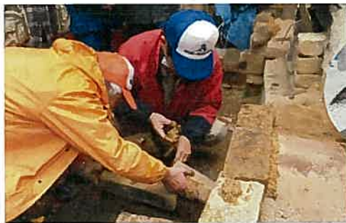
⑦ 赤土を粘土状にして隙間に詰め、さらにレンガを置き換えて、微調整。
