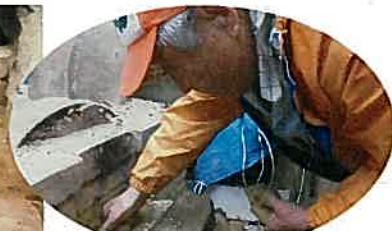
⑦ 赤土を粘土状にして隙間に詰め、さらにレンガを置き換えて、微調整。
