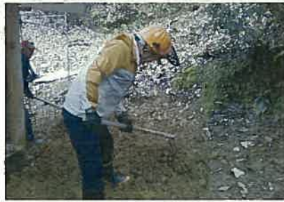
小屋周辺の拡張工事中
