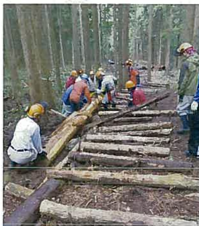
転倒した直径40cmの丸太を積み直す
